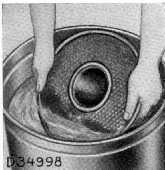
Bild 43. Unteren Filtereinsatz auswaschen
