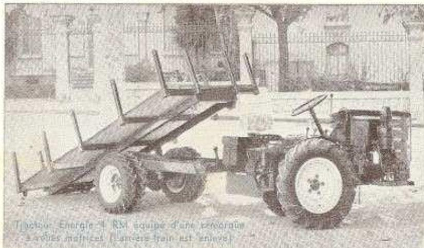
Tracteur Energie 4 RM équipé d'une remorque à deux roues motrices (l'avant-tract est enlevé)
