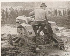
Le tracteur R 22 muni de ses chenilles amovibles le transformant en half-track et lui assurant une puissance au crochet beaucoup plus élevée
