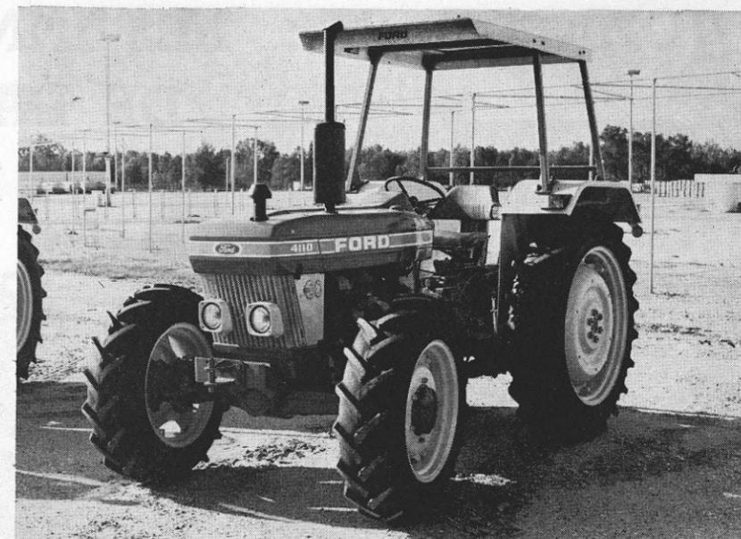
**SUR CETTE PHOTO DU TRACTEUR « 4110 » ON REMARQUERA LE PONT AVANT CENTRÉ ET LA PARTIE AVANT RELEVABLE DU CAPOT POUR DONNER ACCÈS AU FILTRE À AIR (Photo RTMA)**
